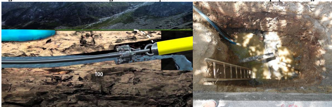
Figura 5 e 6 - Método HDD e chegada da tubulação PEAD onde será construído o poço de desague
